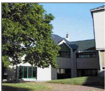
L'IRCOM situé aux Ponts de Cé, offre un cadre de travail exceptionnel...
